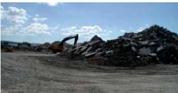
Beseitigung von Betonfundamenten.
