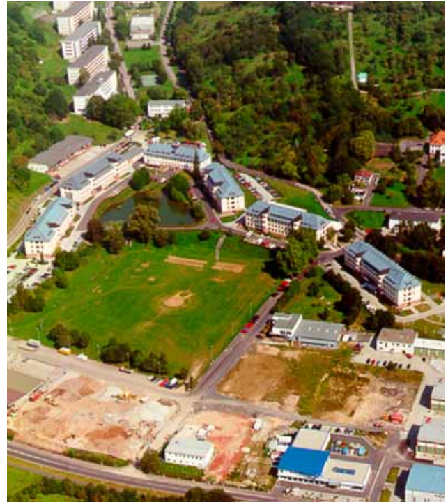
für die neue Zufahrt waren erhebliche Tiefbauarbeiten nötig.
