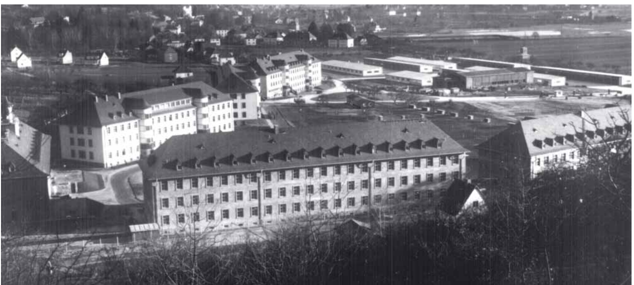
Der Kasernenkomplex vor dem 2. Weltkrieg, im Hintergrund die Stadt Gelnhausen.
