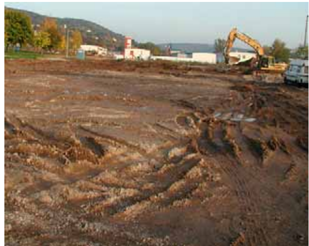
Umfangreiche Tiefbauarbeiten prägten über mehrere Jahre das Bild.
