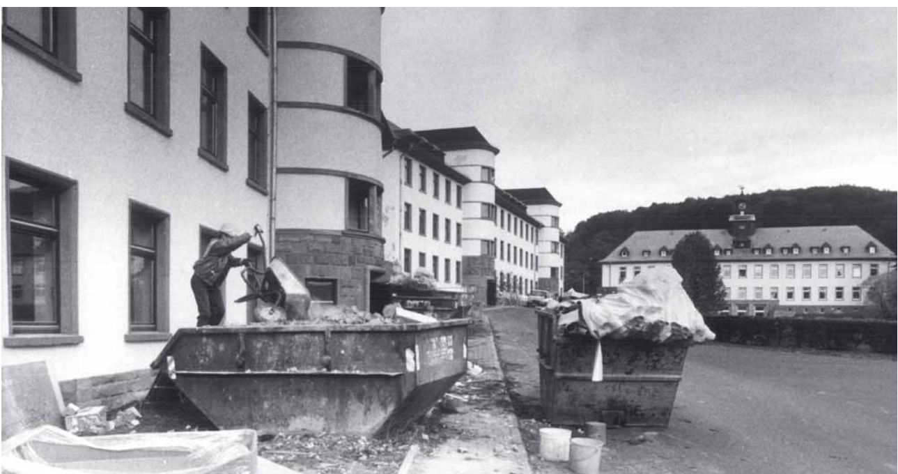
Unmittelbar nach Abzug der US-Armee begannen umfängliche Modernisierungsarbeiten.
