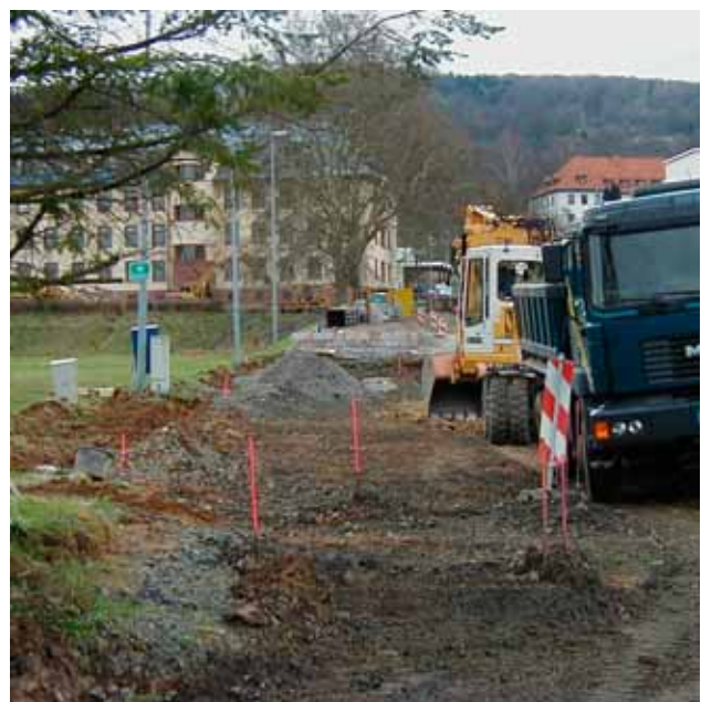
Straßen wurden entweder repariert oder wie im Bereich der Einfahrt neu angelegt.
